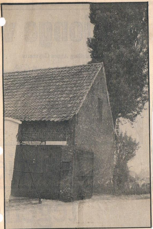
WELDEN-OUDENAARDE. — In de Corpusstraat van deelgemeente Welden staat ook al die landelijke schuur in de weg, daar die weg moet verbreed worden...
